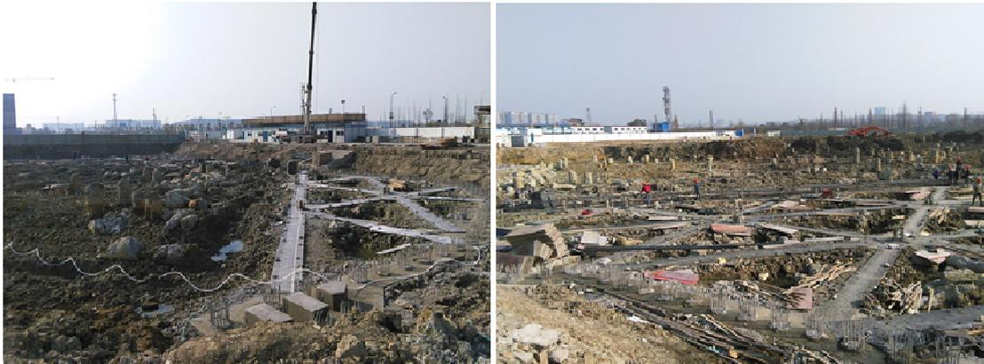
紫金港校区西区学生生活区组团1#、2#楼于11月28日完成全部打桩工作,比计划提前15天,基桩静载试验和抗拔试验检测完成,检测符合设计要求,目前正在组织土方开挖及支撑梁、压顶梁的施工。根据施工进度计划,该项目将于2015年1月底之前完成1/3的地下室底板施工,5月中旬完成全部地下室及基础工程施工。目前,弱电工程正在进行清单编制工作,预计2015年2月初进行开标工作。
