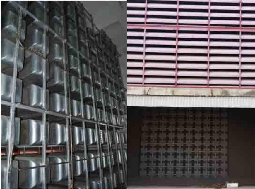
图 4-5 风洞噪声防治措施（吸声器）
